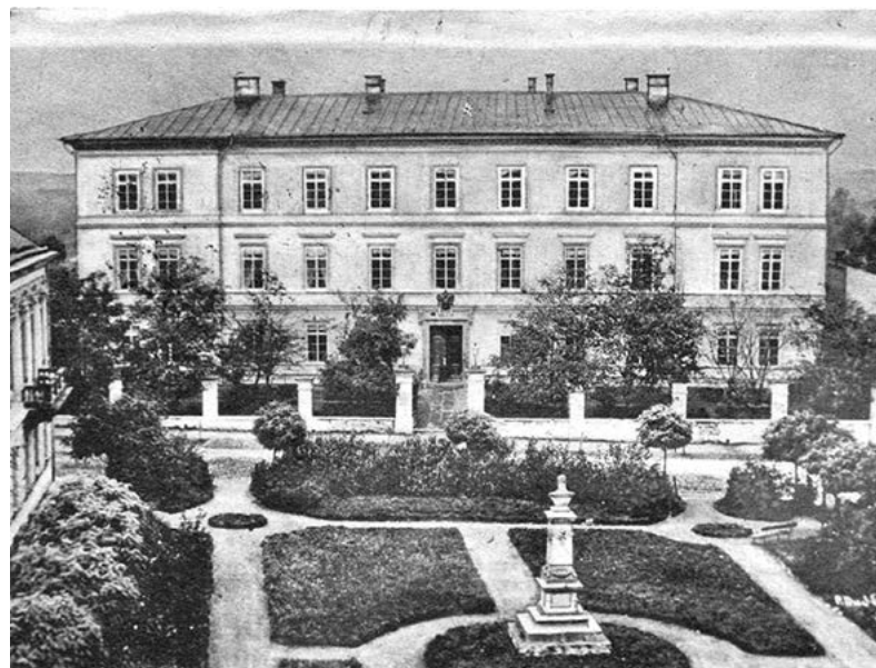
BUDYNEK WADOWICKIEGO GIMNAZJUM NA POCZTÓWCE WYDANEJ PRZEZ C. TOMASIEGO (DOMENA PUBLICZNA)
