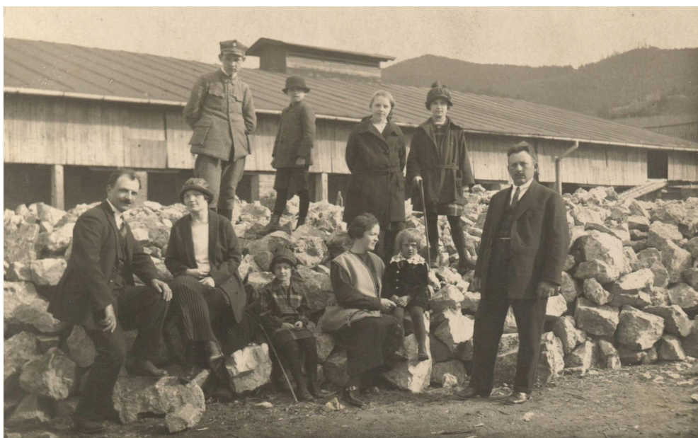
Rodzina Baselidesów oraz Wiśniowskich w kamieniołomie w Inwałdzie
