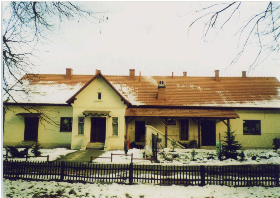
Leśniczówka w Rzykach wybudowana z inicjatywy Teodora Drapelli w 1898 roku, autor fot. J. Wnęczak
